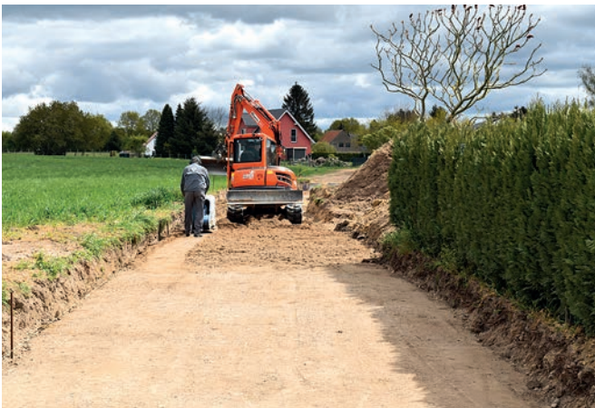
Erdarbeiten jeglicher Art
