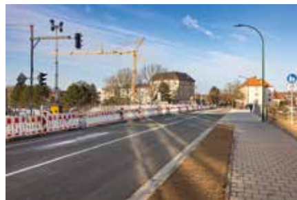
Markkleeberg aktuell Koburger Straße für Verkehr freigegeben
