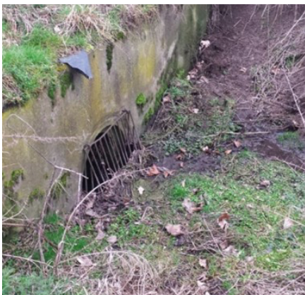
Beginn der Verrohrung in der Feldlage
